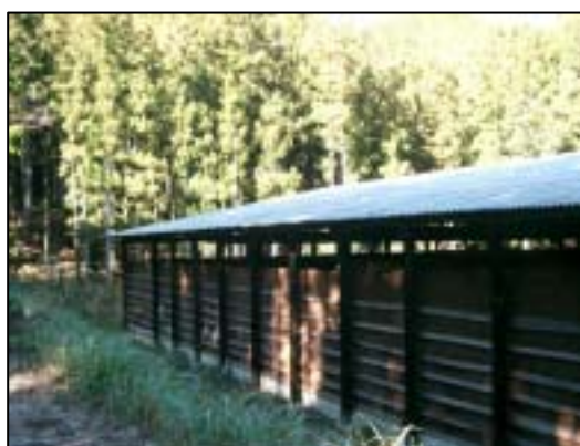
大型堆肥舎（側面）
