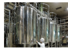
生クリーム貯蔵タンク
