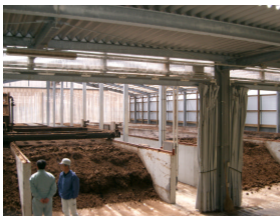
発酵舎投入口
