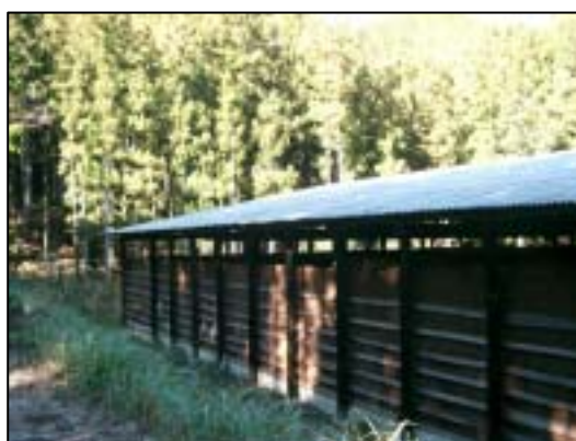
大型堆肥舎（側面）
