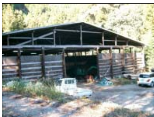
大型堆肥舎（正面）
