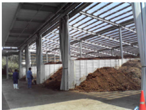
同センターの堆肥舎全景
