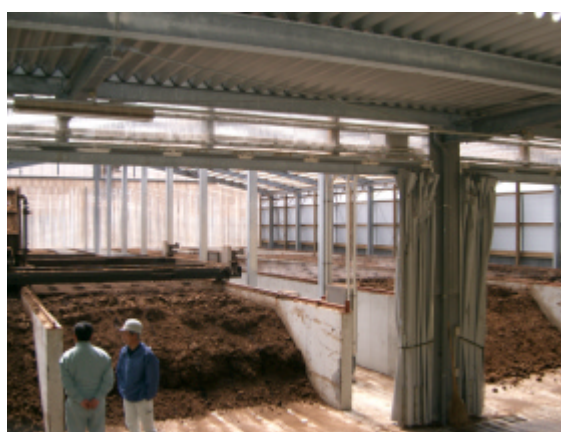
発酵舎投入口
